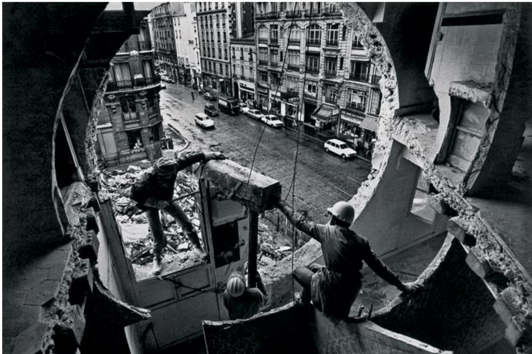
Gordon Matta-Clark et Gerry Hovagimyan travaillant à « Conical Intersect », rue Beaubourg, à Paris, en 1975. HARRY GRUYAERT/MAGNUM PHOTOS
